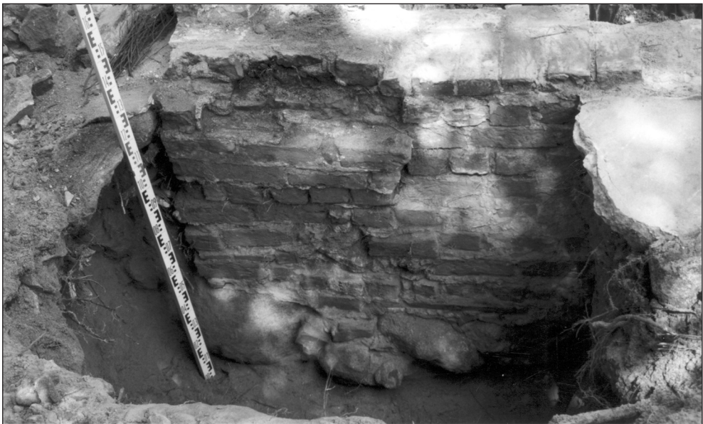
Ilustr. 10. Sondaż nr 8. Fragment zachodni lica zewnętrznego ściany południowej oraz lico południowe ściany zachodniej, widok od południa. Fot. A. Uciechowska – Gawron
